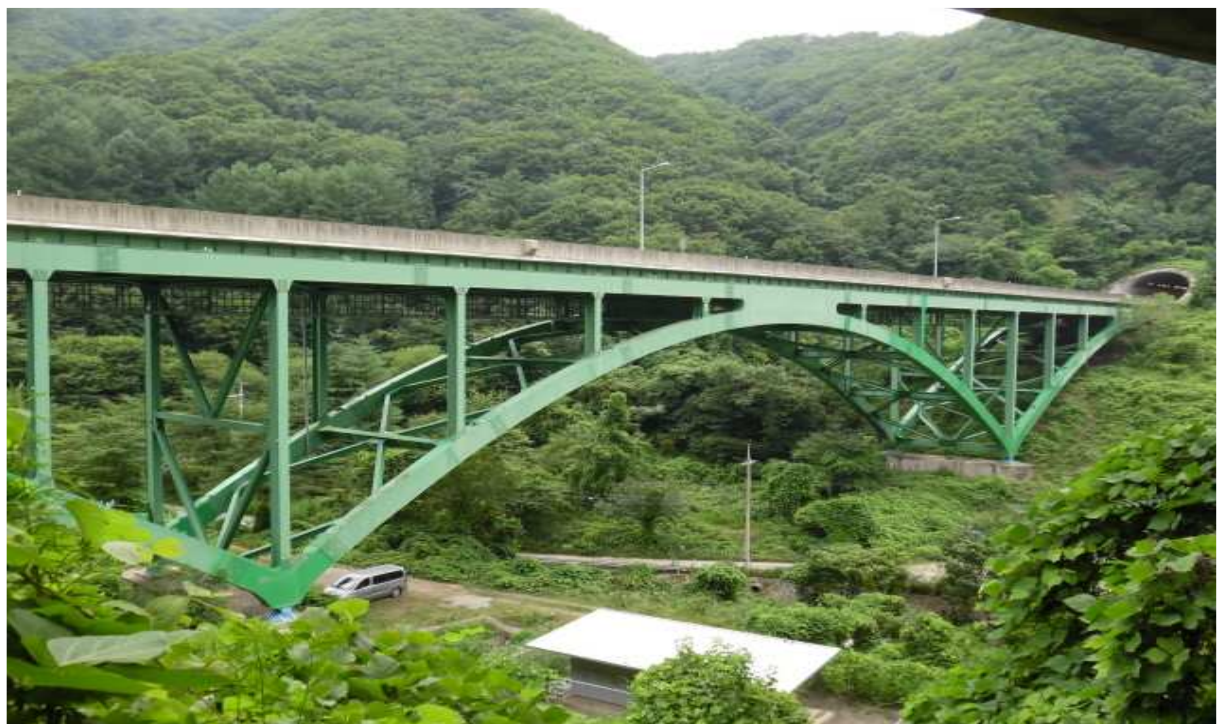
백운1교(부산) 측면 전경
