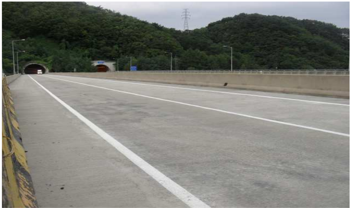
백운1교(부산) 상부 전경
