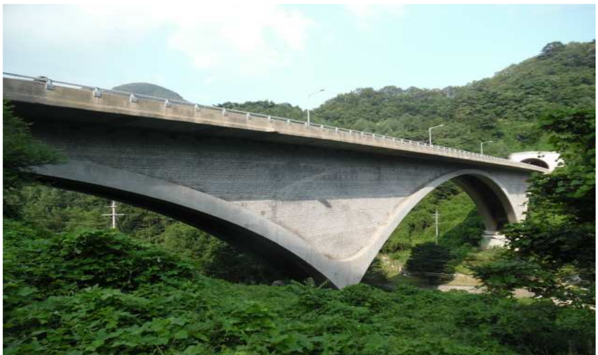
백운1교(춘천) 측면 전경
