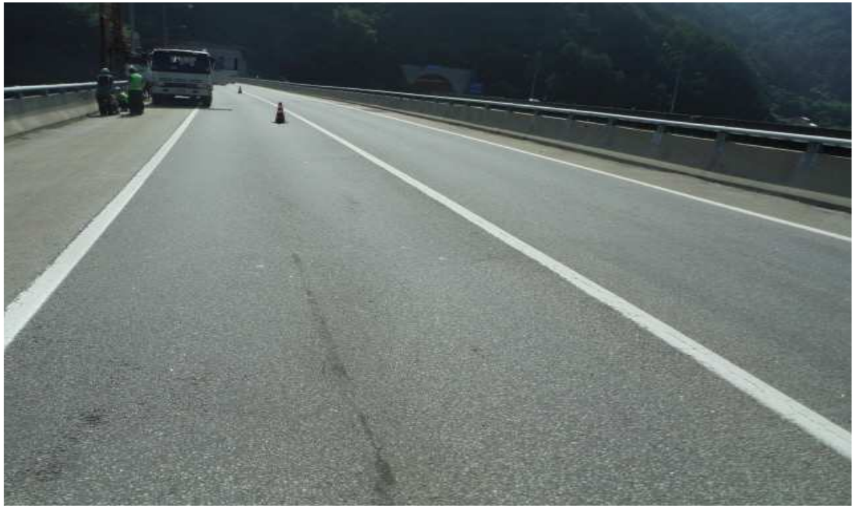
백운1교(춘천) 상부 전경
